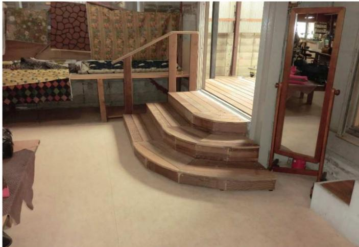
写真は杉材ですが、斜面地の階段に高強度耐久性木材で設置すると腐らない強固なものができます。
